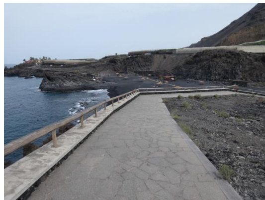
Vista general del acceso sur.
