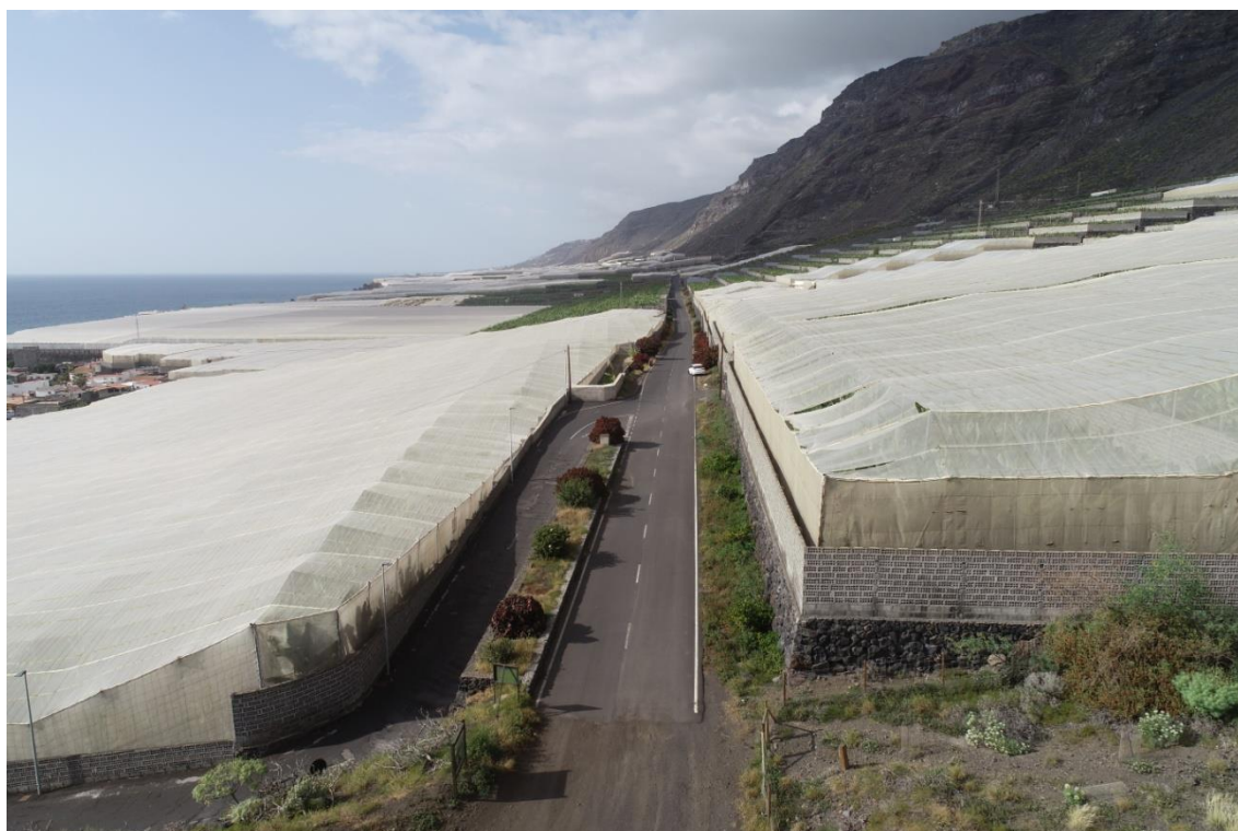
Tramo final de la carretera LP-213 en el extremo sur del E.N.P.
