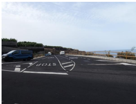
Vista general del acceso sur con sus diferentes líneas de estacionamientos, visto desde la LP-213.
