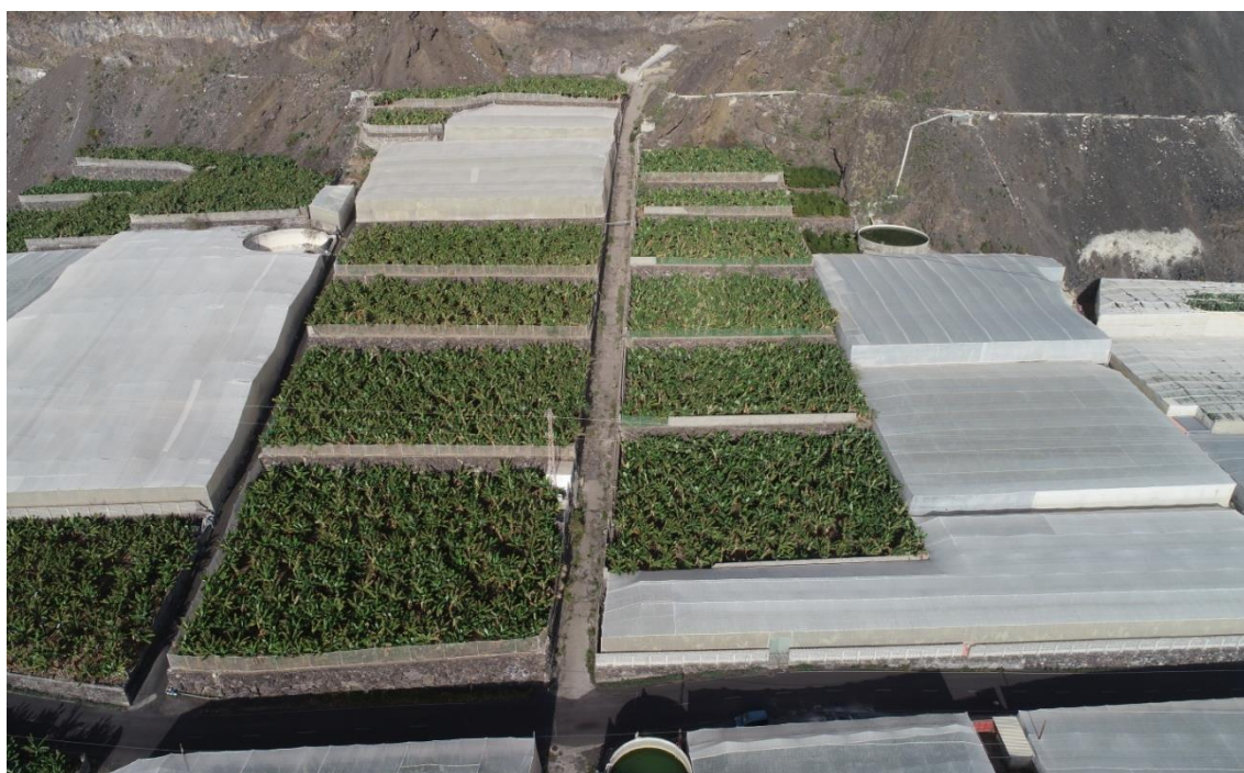
Vista aérea de una de las numerosas pistas agrícolas que discurren por el E.N.P. A su vez, esta pista actúa como cauce del Barranco de Los Guanches, obstaculizando la vía LP-213 cuando se producen fenómenos de precipitación intensas.
