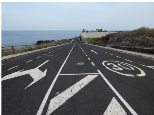
Vista general del acceso norte con sus estacionamientos en línea (3 Uds.), visto desde la LP-213.
