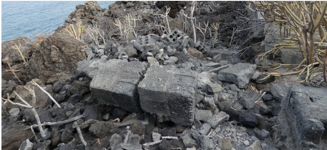
Detalle de una zona de la franja litoral donde se han depositado los escombros de una antigua pared de bloques huecos.
