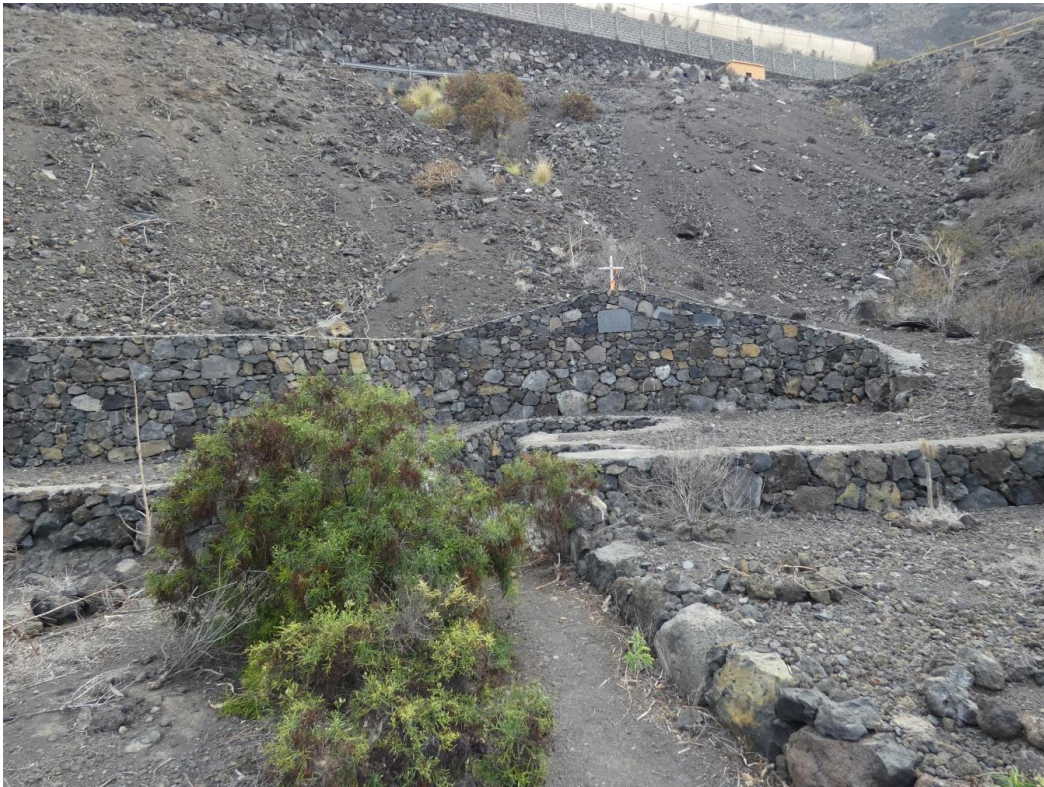
Detalle del estado actual del entorno más próximo al pozo de Las Cruces.
